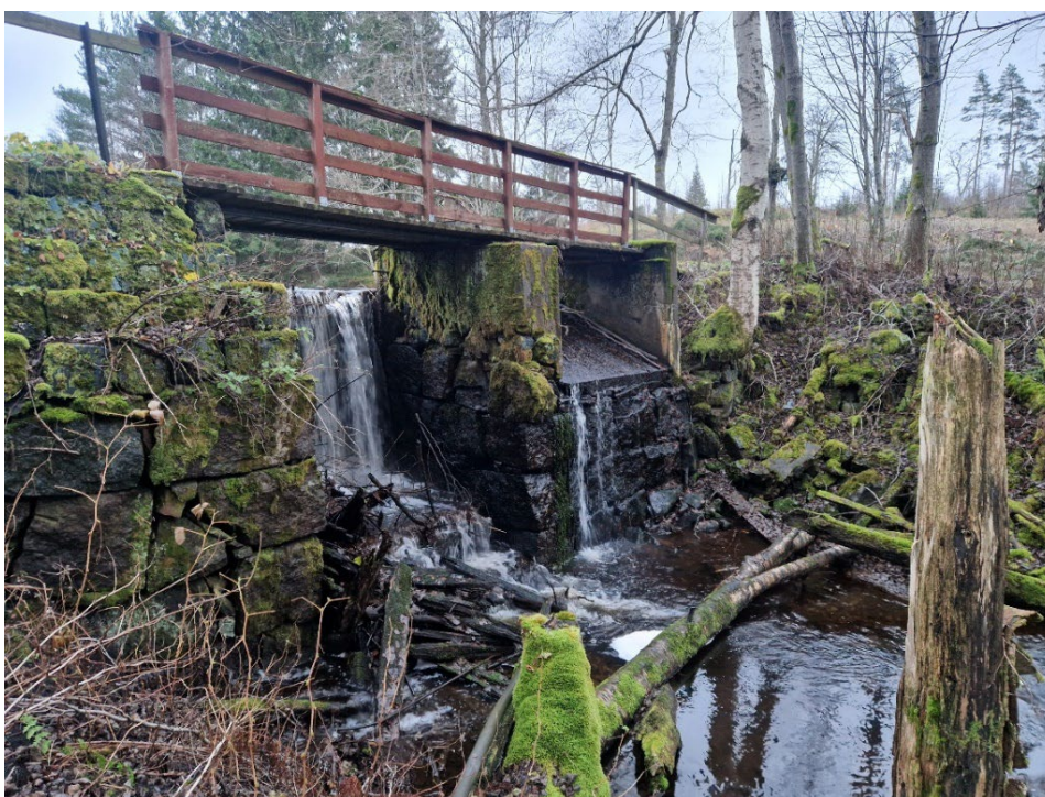
Figur 37. Dammen nedströms länsväg 761.
